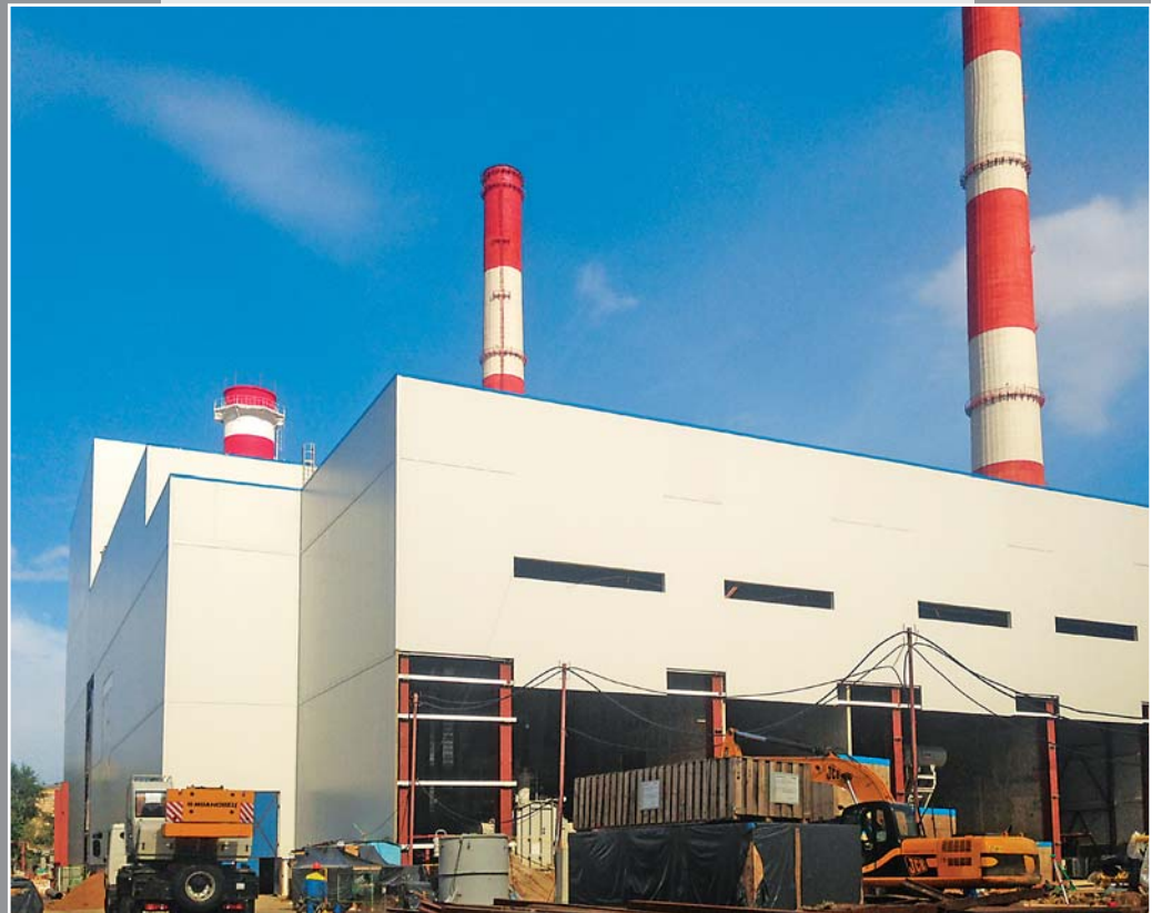
ТЭЦ-12, Здание КРУЭ, г. Москва (2012-2014 г.)
