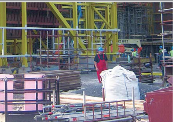
Шефмонтаж, Поставка сэндвич-панелей 4000 м 2
