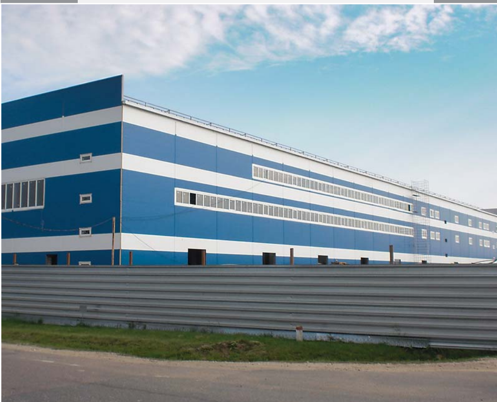
Складской комплекс «Сити-Строй» на территории «Ногинск-Технопарк», г. Ногинск (2013 г.)
