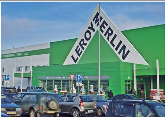
Строительно-монтажные работы, Поставка сэндвич-панелей 5500 м 2
