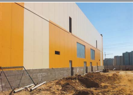
Строительно-монтажные работы, Поставка сэндвич-панелей 10800 м 2
