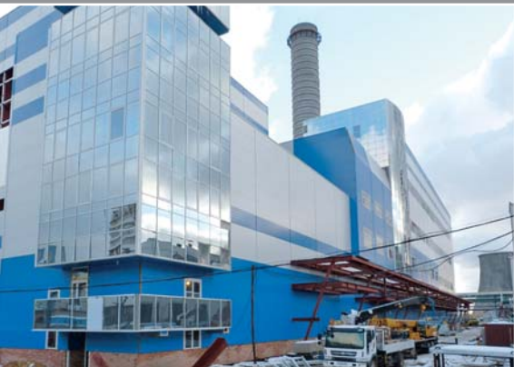
Строительно-монтажные работы, Поставка сэндвич-панелей 12000 м 2
