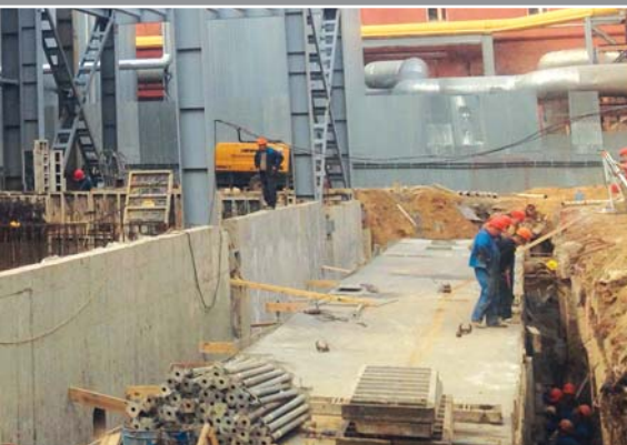
Строительно-монтажные работы, Поставка сэндвич-панелей 17000 м 2
