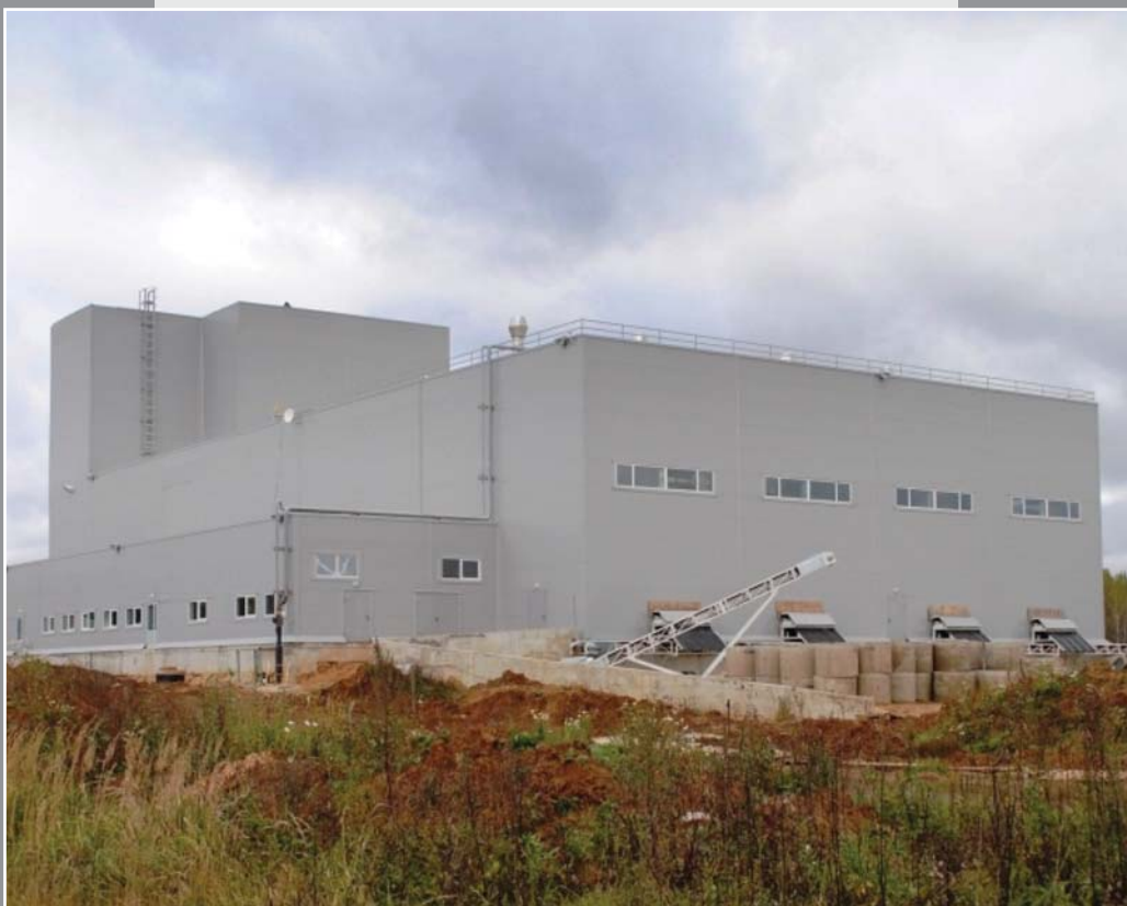
Завод "Пеногазостекло-Калуга", Калужская область, Боровский район, д. Коряково (2013г.)
