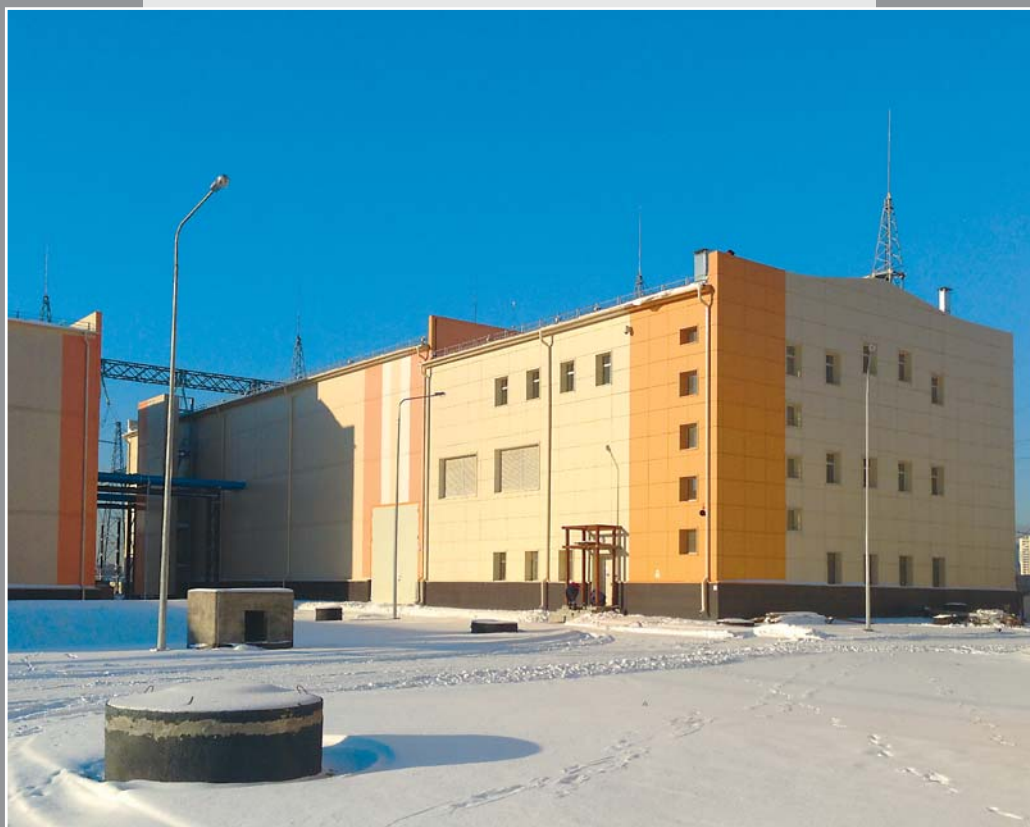
Подстанция «Каскадная», г. Москва (2010-2012г.)
