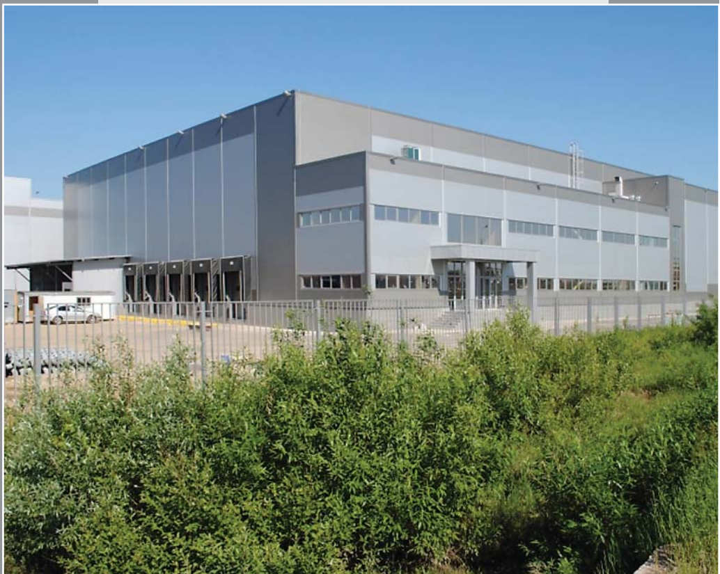
Офисно-складской комплекс "Диалог Инвест", д. Лешково, Московская обл. (2012 г.)
