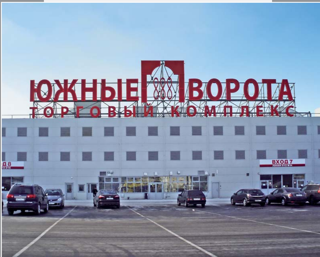
Торговый комплекс "Южные ворота", г. Москва, 19 км МКАД, (2009-2010 г.)
