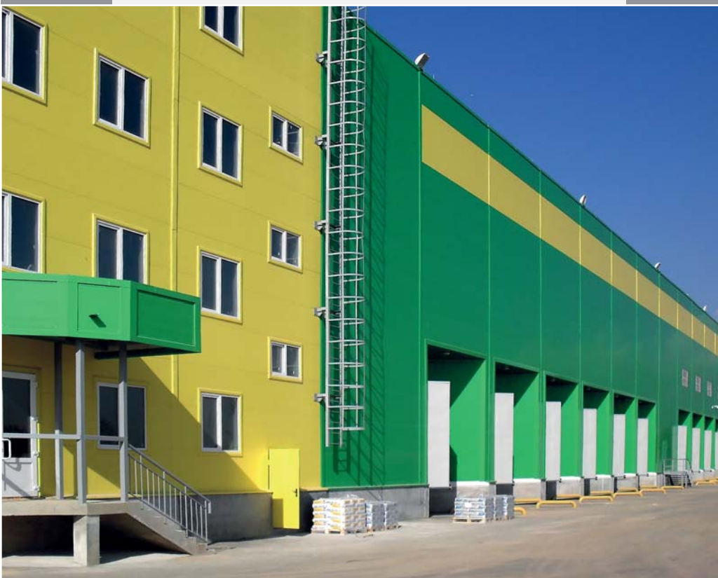
Сельскохозяйственный складской комплекс, д. Сырково, Московская обл. (2008 г.)
