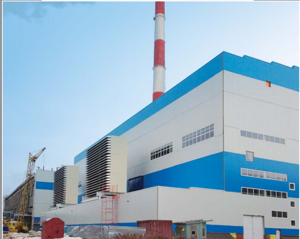
Новогорьковская ТЭЦ, Нижегородская обл., г. Кстово (2013 г.)
